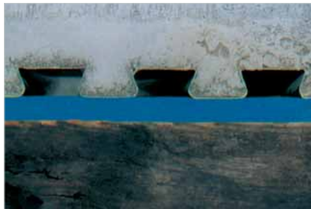
Sylomer ® -TSS Schallschutzstreifen auf Holzbalkendecke mit vergossenen LEWIS ® -Schwalbenschwanzplatten in der Anwendung
