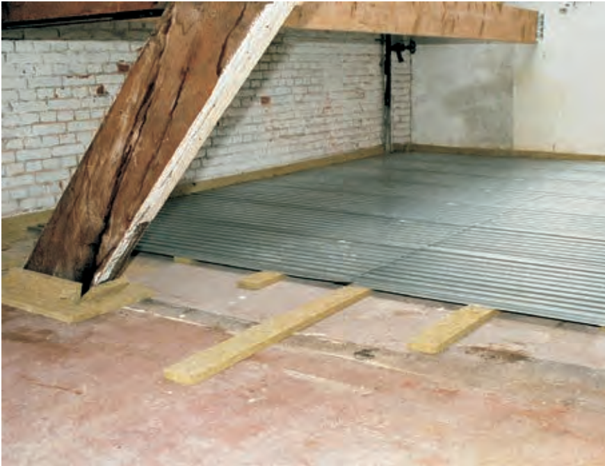
LEWIS®-Schwalbenschwanzplatten verlegt auf mineralischen Luft- und Trittschallstreifen
