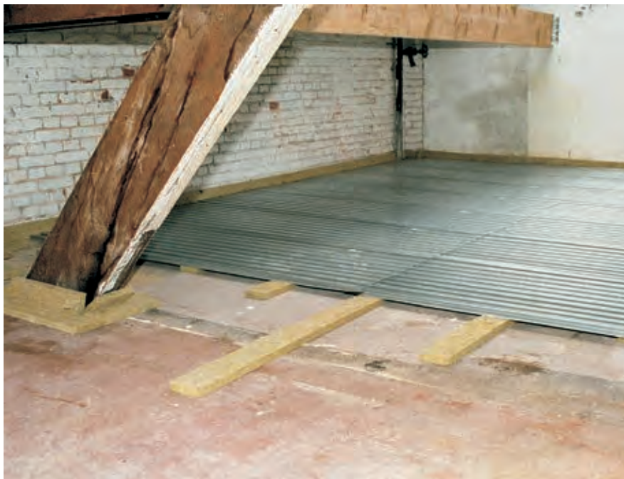
LEWIS®-Schwalbenschwanzplatten verlegt auf mineralischen Luft- und Trittschallstreifen
